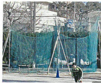
投てき用防護ネット（R2新設）
